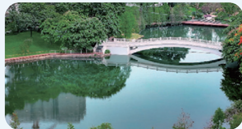
生態工程修復後
