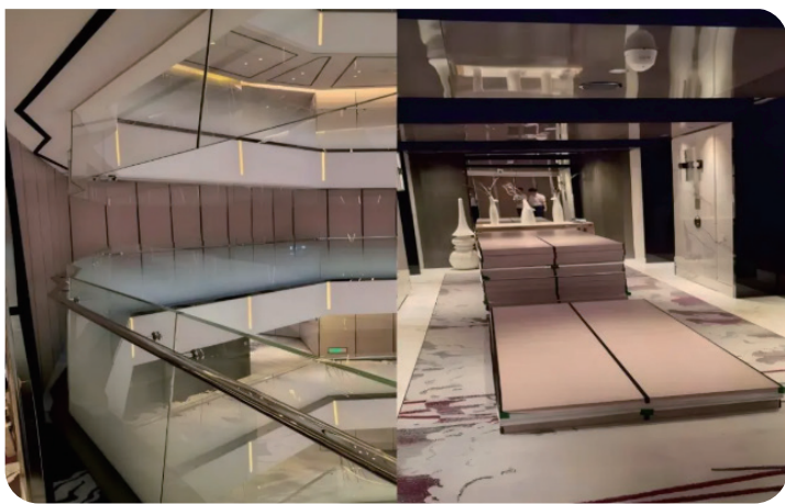
圖：封閉式圍擋及模組化裝配，隔絕噪音、粉塵和氣味，確保賓客環境的健康
