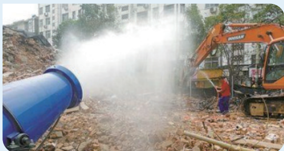
場地防塵：霧炮機
