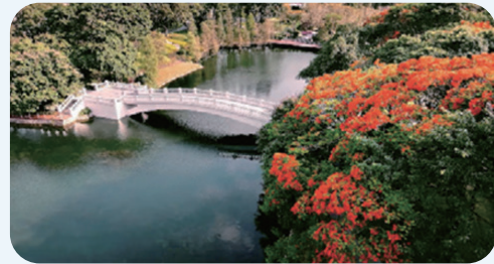
生態工程修復後
